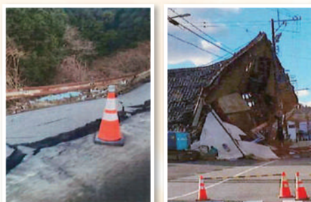
能登町内の被災状況
