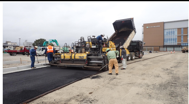
舗装工事状況
