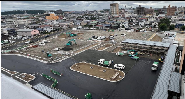
外構整備状況
