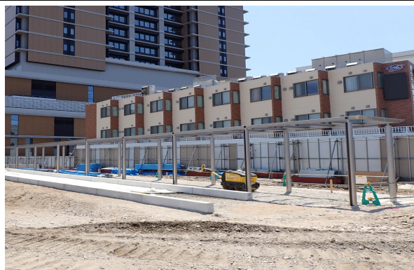
屋根付駐輪場（鉄骨工事）
