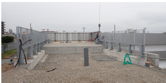
北東車路（手摺取付）
