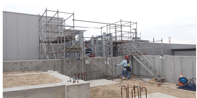
連絡通路（鉄骨組立）
