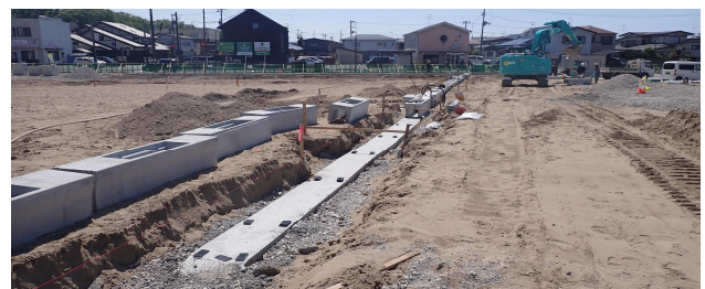
排水整備（側溝据付）
