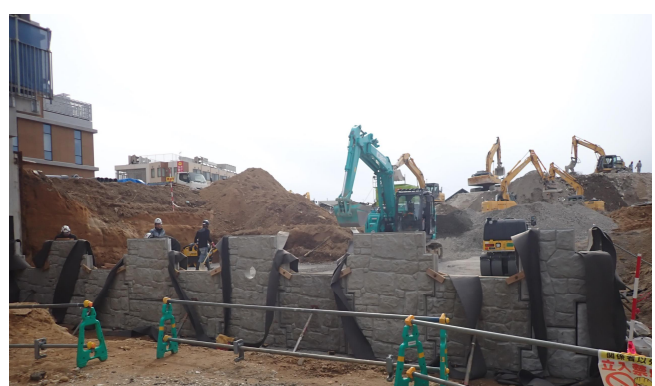
補強土壁工事
