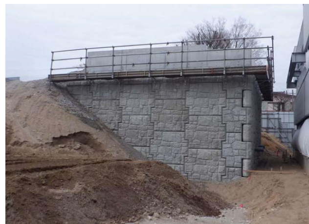
補強土壁工事
