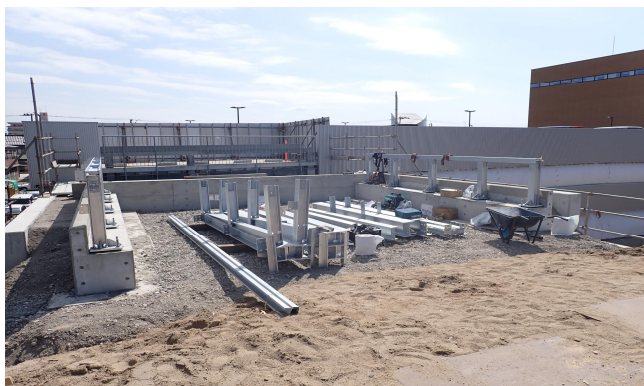
北東車路 鉄骨組立状況
