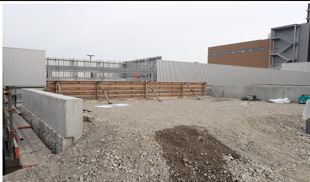
北東側車路基礎工事
