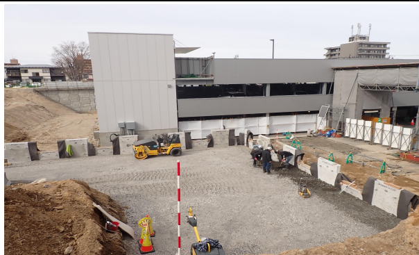
補強土壁工事
