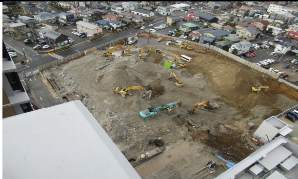
上屋解体状況
