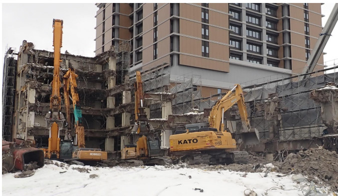
病棟 解体状況
