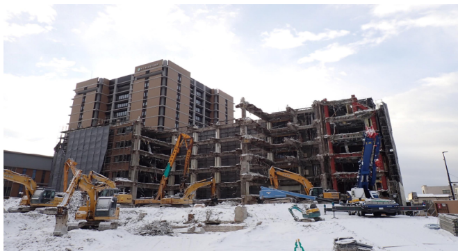
病棟 解体状況
