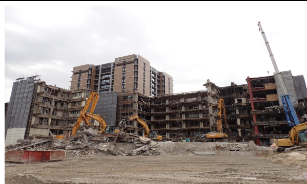
病棟（南側） 解体状況
