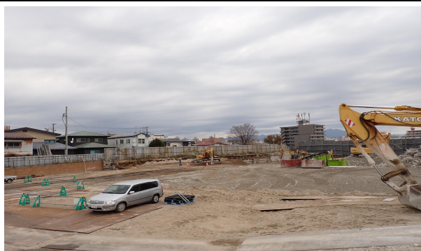
診療棟（地階） 解体状況
