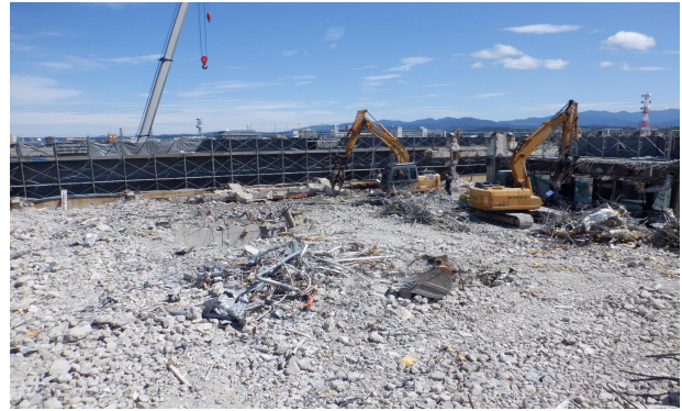
病棟（7階） 解体状況
