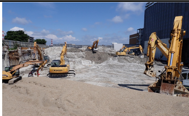
診療棟地階 埋戻し状況
