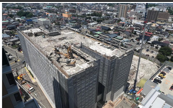
病棟8階 解体状況
