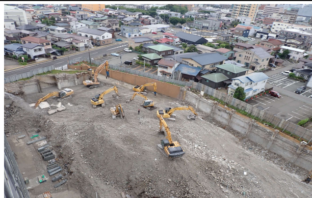
診療棟 解体状況
