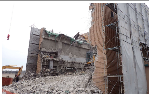
病棟 解体状況
