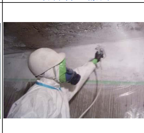
除去後の粉じん飛散防止処理剤の散布
