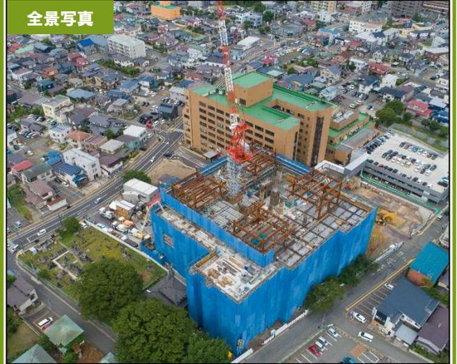
医療支援棟は、土工事（掘削）がまもなく終了し、7月からは基礎部分の配筋、型枠およびコンクリート工事を行います。
