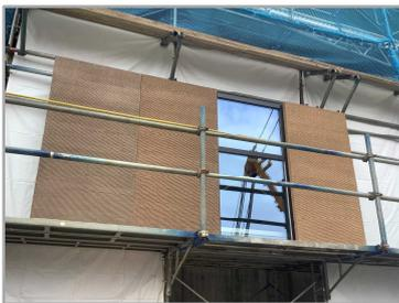
モックアップとは検討や確認のために試作する「模型」のことです。今回は低層部分の外装モックアップを作成し、外装材や窓の質感、色などを確認しました。
