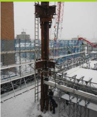
鉄骨建方状況
