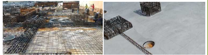
スラブ配筋状況
