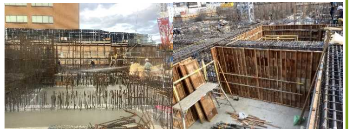
打設後散水状況
