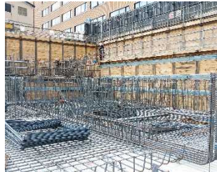
鉄筋組立状況
