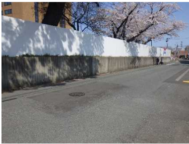
東側仮囲い設置
