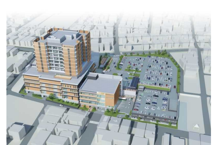
外観イメージ(東側全体)
